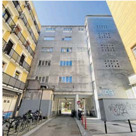
Parte trasera de La Redería, que sirve de conexión entre plazas.
