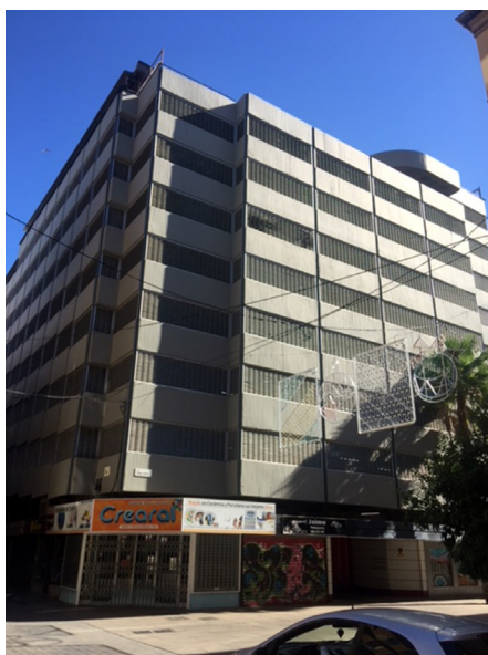
EDIFICIO APARCAMIENTOS C/ TOMÁS HEREDIA. 1973-1975. Arq. José Luis Esteve Balzola y Pedro Aparicio Escobar. Málaga.
