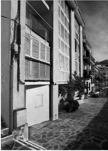
contenido: vista exterior Apartamentos Pienc autoría de la imagen: Rafa Zuza/Fundación DOCOMOMO Ibérico fecha de realización: 2007
