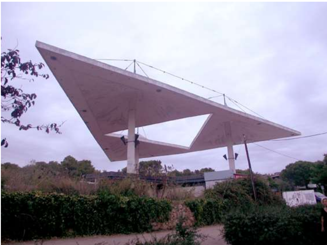
Centro Comercial Politur , Platja d'Aro, 1963, Josep Puig Torné y Josep Maria Esquiús, estructura de hormigón: Antoni Bonet Castellana © Eva Jiménez y Xavier Llobet/Fundación DOCOMOMO Ibérico
