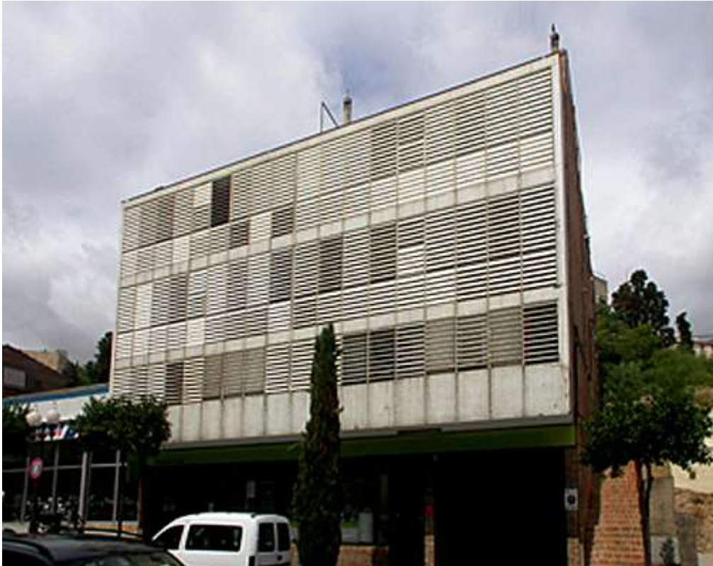
Edificio Renault , Tarragona, 1964, Antoni Bonet Castellana y Josep Puig Torné © Eva Jiménez y Xavier Llobet/Fundación DOCOMOMO Ibérico
