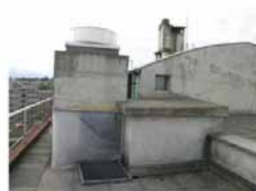
toiture nord ouest, 9e
