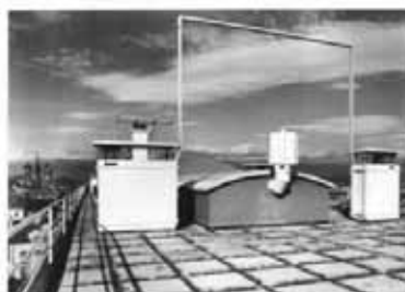
toiture est, 9e
