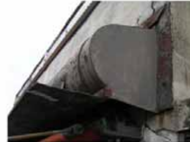
façade ouest, 8e
