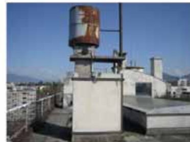
toiture nord ouest, 9e
