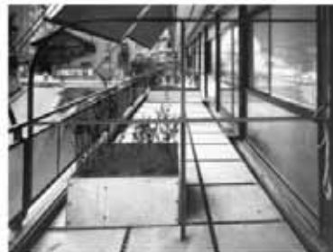
façade sud, 1er
