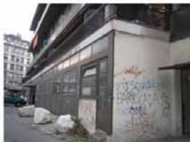
façade sud, rdc
