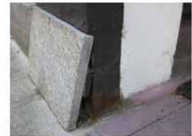
façade nord, rdc, travée 17
