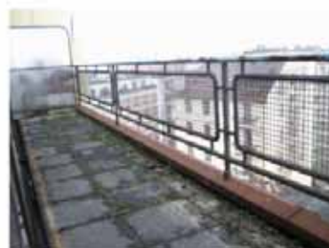
façade nord, 8e
