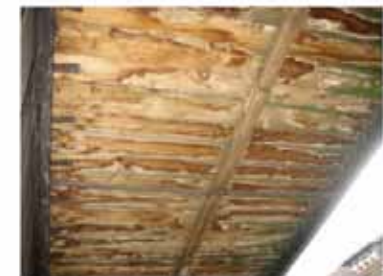
façade nord, sous balcon 3e
