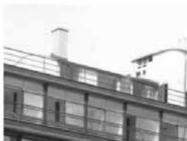
toiture sud ouest, 9e
