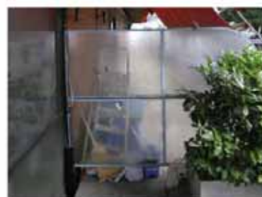
façade sud, 1er, travée 16
