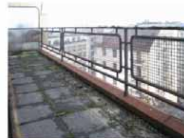
façade nord, 8e, travées 11/14
