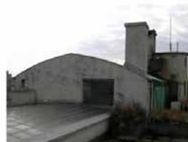
toiture sud ouest, 9e
