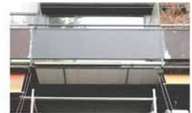
façade sud, sous balcon 2e, travées 4/5
