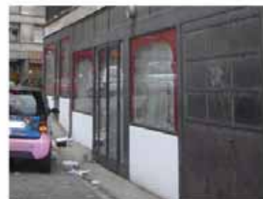
façade sud, rdc, travées 13/18
