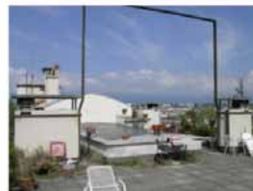
toiture est, 9e
