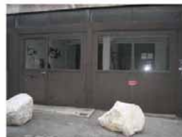
façade sud, rdc, travées 4/6
