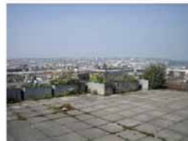
toiture ouest, 9e
