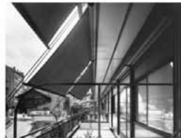
façade sud, sous balcon 2e
