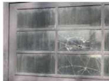
façade sud, rdc, travées 12/13
