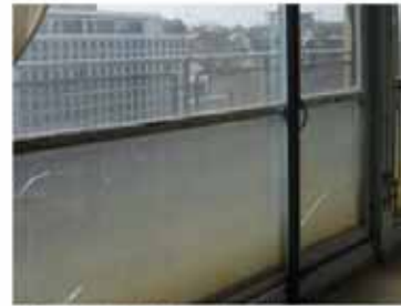
façade nord, 8e, travées 11/12
