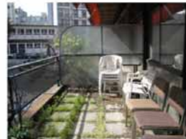
façade sud, 1er, travées 4/7
