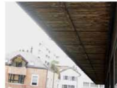
façade nord, sous balcon 3e
