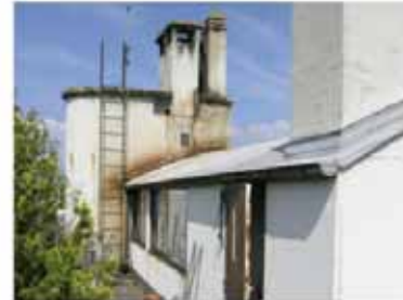
toiture sud est, 9e
