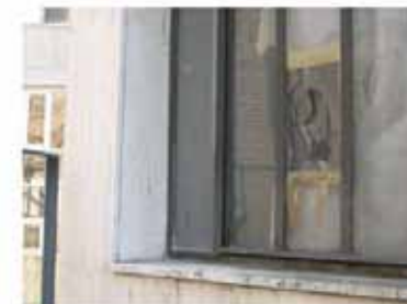
façade nord, rdc, travée 2
