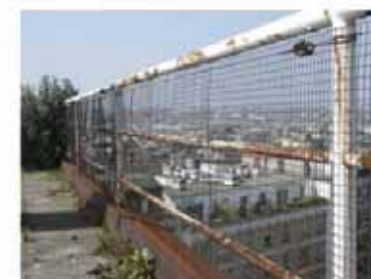
façade nord, 9e
