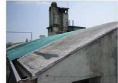
façade nord, 9e
