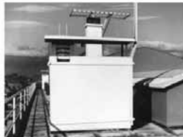
toiture sud est, 9e
