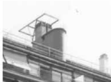
toiture sud, 9e
