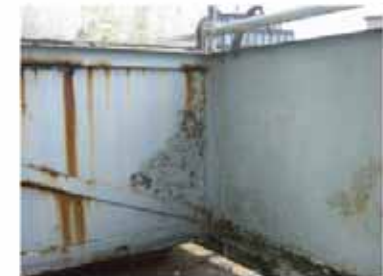
façade sud, 6e, travée 13
