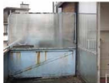
façade sud, 6e, travée 16
