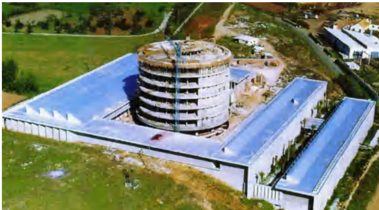
Figura 3. Vista aérea del edificio en construcción. Imagen: © AP-CTAV.
