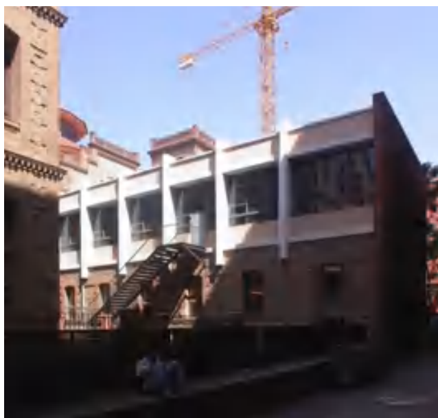
Figura 6. Recinto Can Batlló (Universitat Industrial de Barcelona, antigua fábrica Batlló). Imagen: Eva Jiménez y Xavi Llobet, 2008/ Arxiu Jiménez Llobet Arquitectes.
