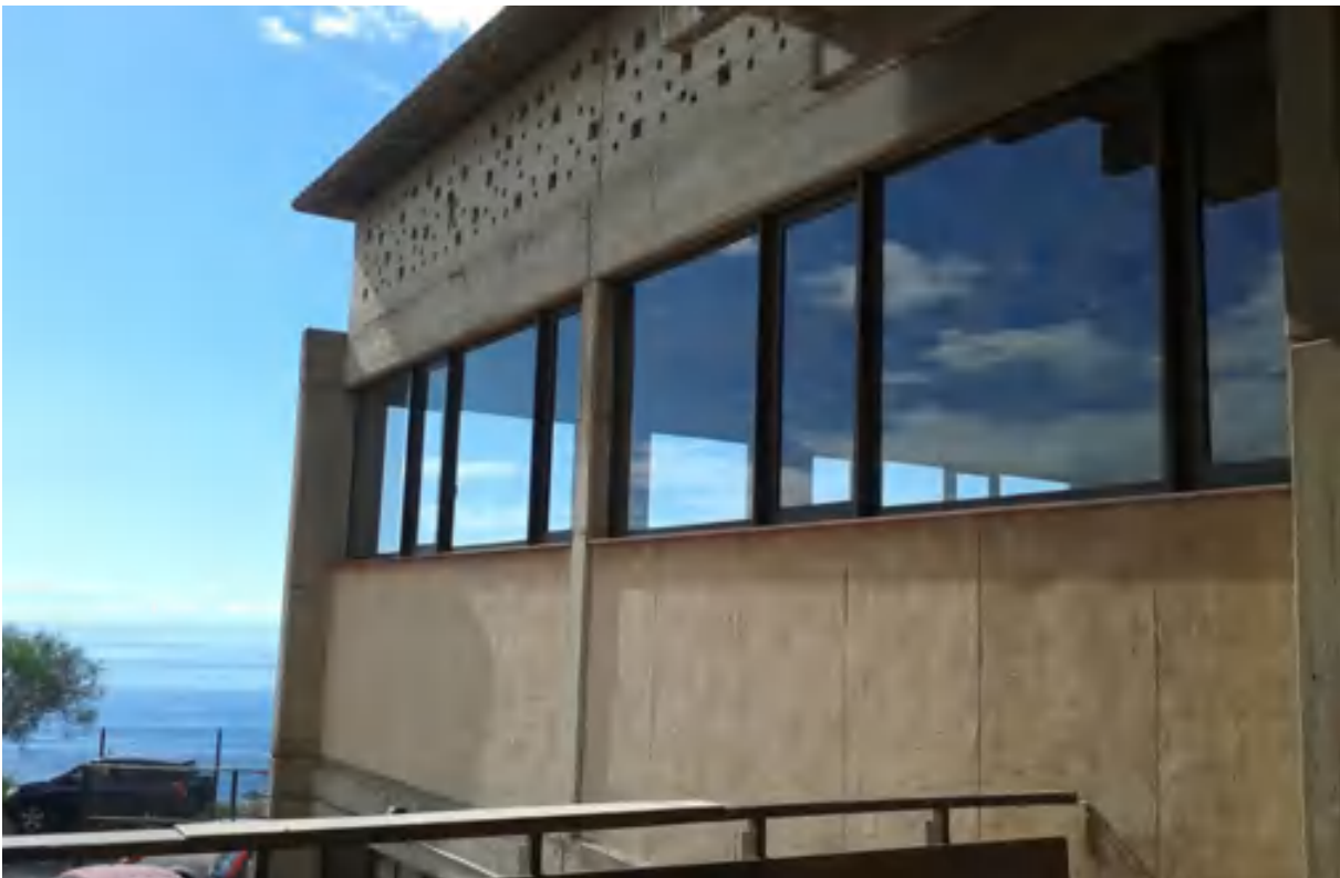
Figura 5. Fachada con paneles prefabricados en pómez. Imagen: Cristina González.
