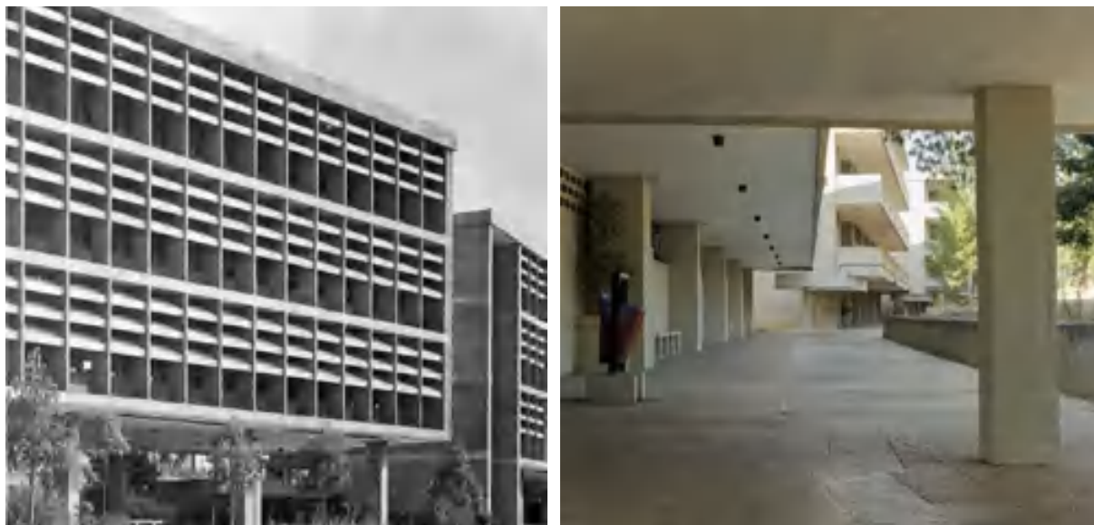
Figura 6a y 6b. Brise-soleils horizontales y escalonados en las fachadas. Fotos: Moreno Barberá, 1970: 19 (izquierda); imagen cedida por Ana Vila (derecha).
