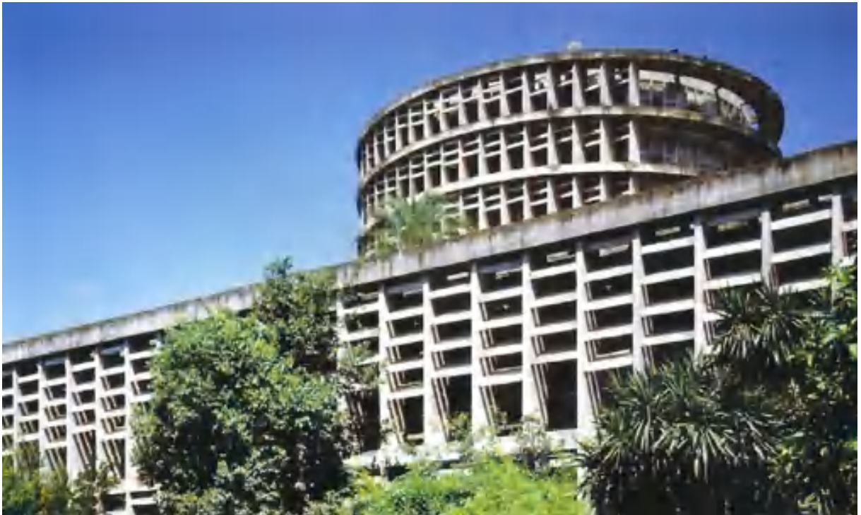
Figura 4. Vista de la fachada sur donde vierten las aulas. Imagen: © AP-CTAV.
