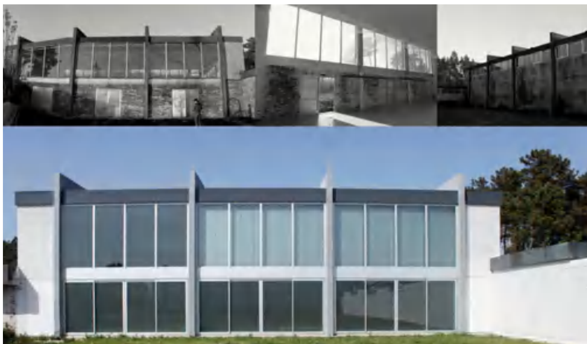
Figura 2. Estado actual y rehabilitación del gimnasio. Imágenes: Luz Paz Agras y Marta Marcos Maroño.
