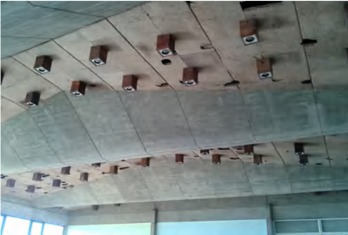
Figura 4. Cubierta del gimnasio mediante vigas prefabricadas en V. Imagen: Cristina González.
