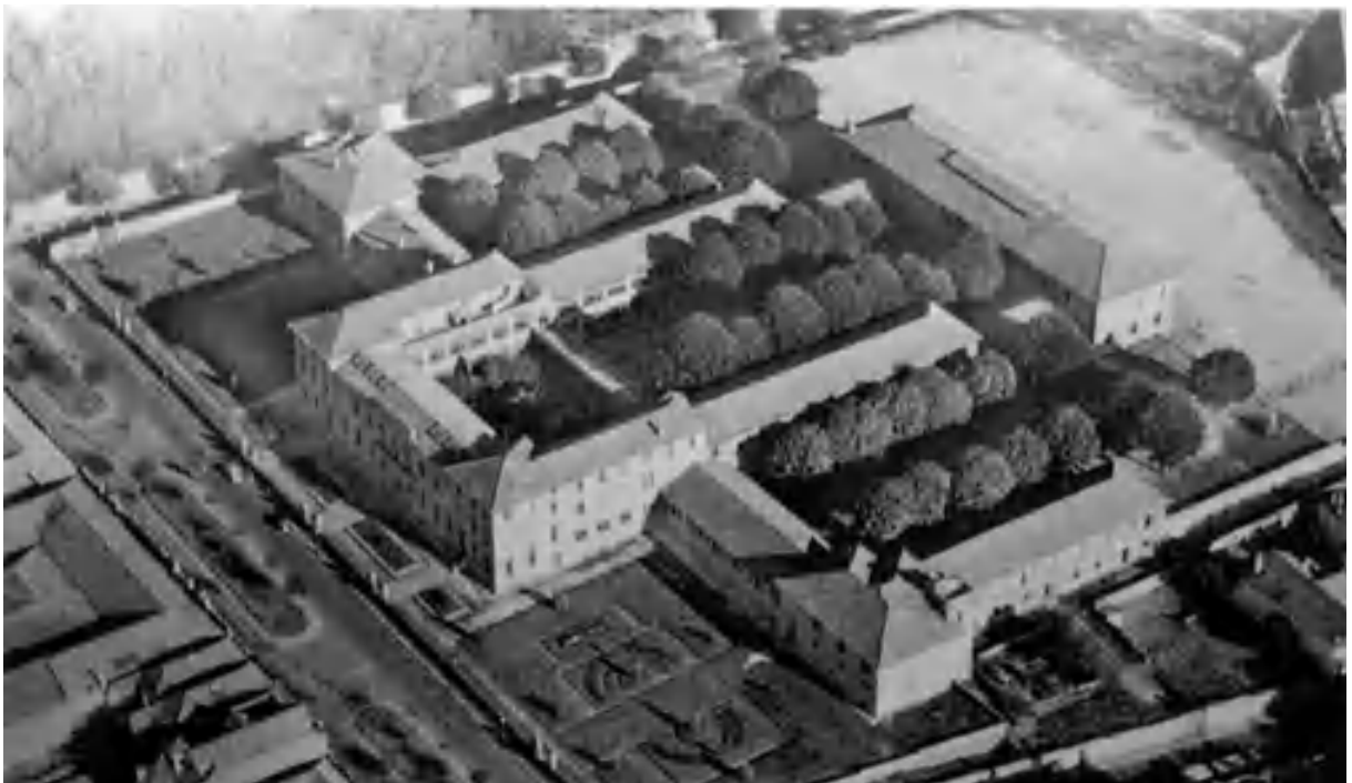
Figura 3. Liceu Alexandre Herculano. Fotografia aérea. Imagem: © Fundação Marques da Silva.
