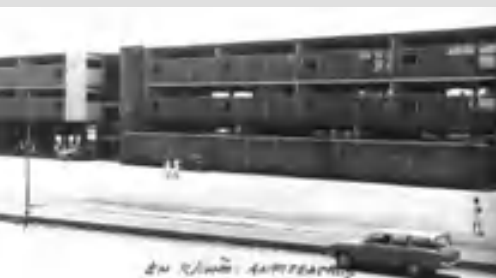
Liceu Nacional do Lobito (1966-1967), Luanda, Francisco Castro Rodrigues. Desenho do edifício, in Almeida, André Fátima, Arquitetura em Clima Tropical: Viagem à obra de Francisco Castro Rodrigues em Angola , Tinta da China, apresentada ao Departamento de Arquitectura da Faculdade de Ciências e Tecnologia da Universidade de Coimbra, 2015, p. 52.
