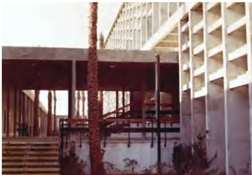
Figura 6. Particular del patio longitudinal flanqueado por las aulas. Imagen: © AP-CTAV.
