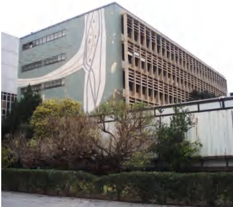
Figura 1. Vista fachadas sur y este. Imagen: Begoña Serrano Lanzarote.
