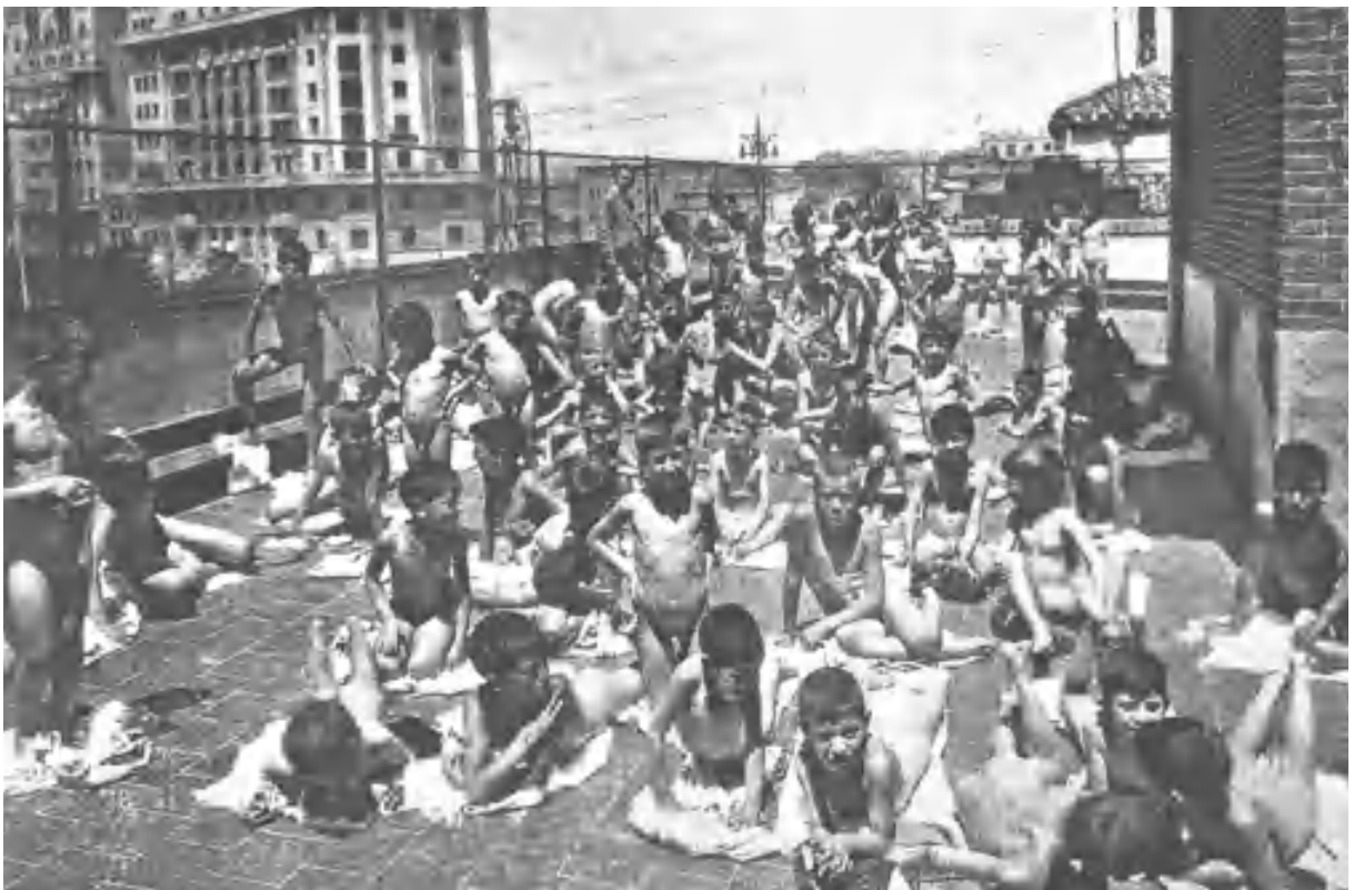
Figura 1. Grupo escolar Cervantes, Madrid 1913-1916. Arquitecto Antonio Flórez Urdapilleta. «Baños de sol en la azotea del grupo escolar, hacia 1933». Imagen: Barona, 2009: 23.
