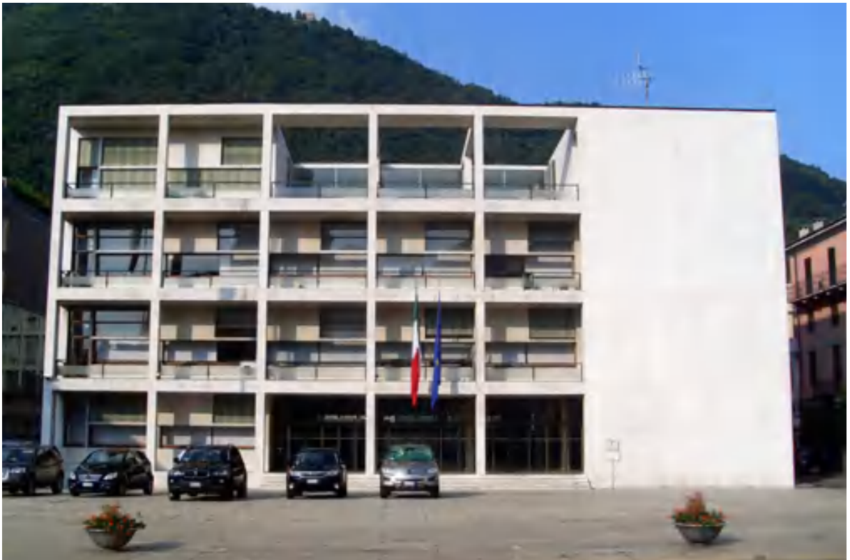
Figura 4. Casa del Fascio proyectada por Guiseppe Terragni (1932-1936). Como (Italia). Foto: Alberto Combarro.
