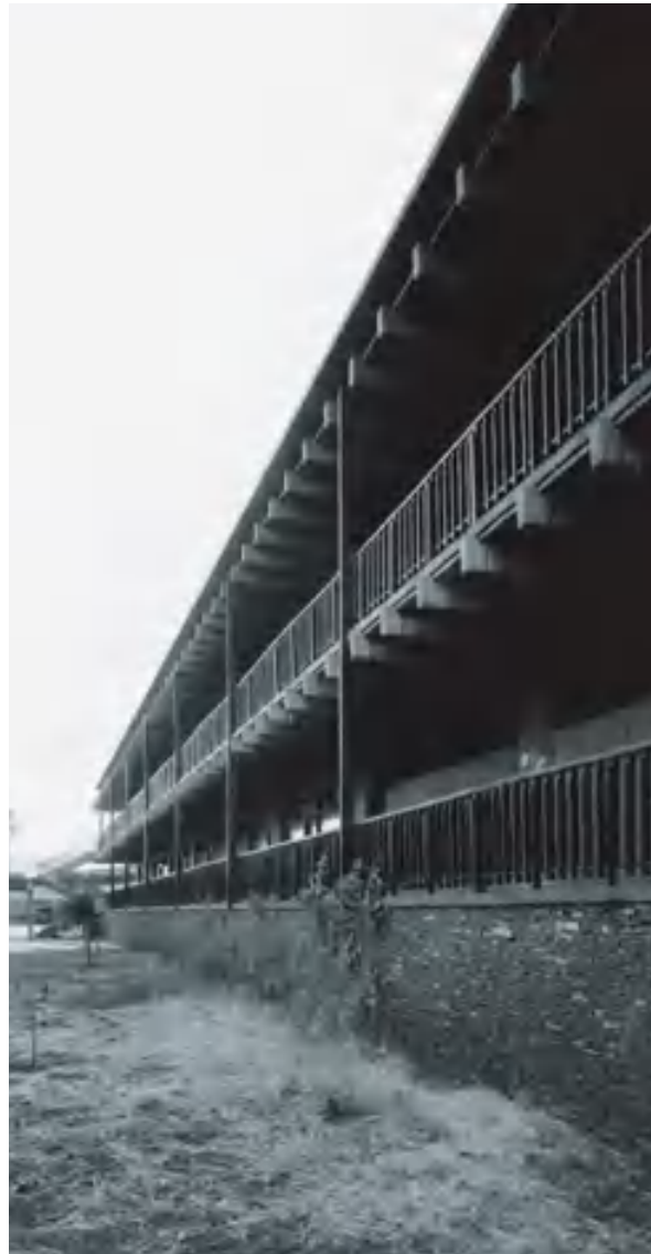
Figura 3. Volumen principal. Balconada con viguetas prefabricadas de hormigón. Fotografía: Jordi Bernadó.
