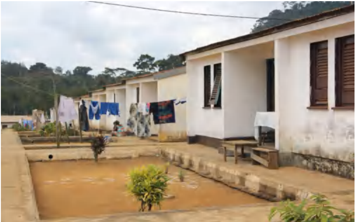
Figura 2. El uso del espacio público como proyección de lo privado puede observarse en múltiples actuaciones. Poblado de Bikurga, 2012. Imagen: © Patrimonio Guinea 2020.
