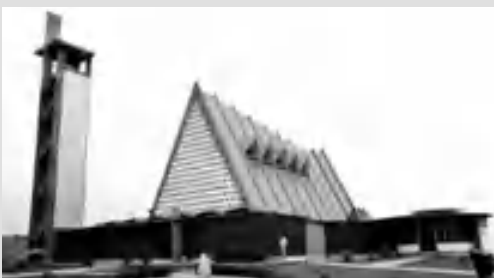
Igreja de Nossa Senhora da Conceição, Luanda, Francisco Castro Rodrigues, 1966, Simões. Imagem resultada de net em http://www.passeidiro.com/photo/30262
