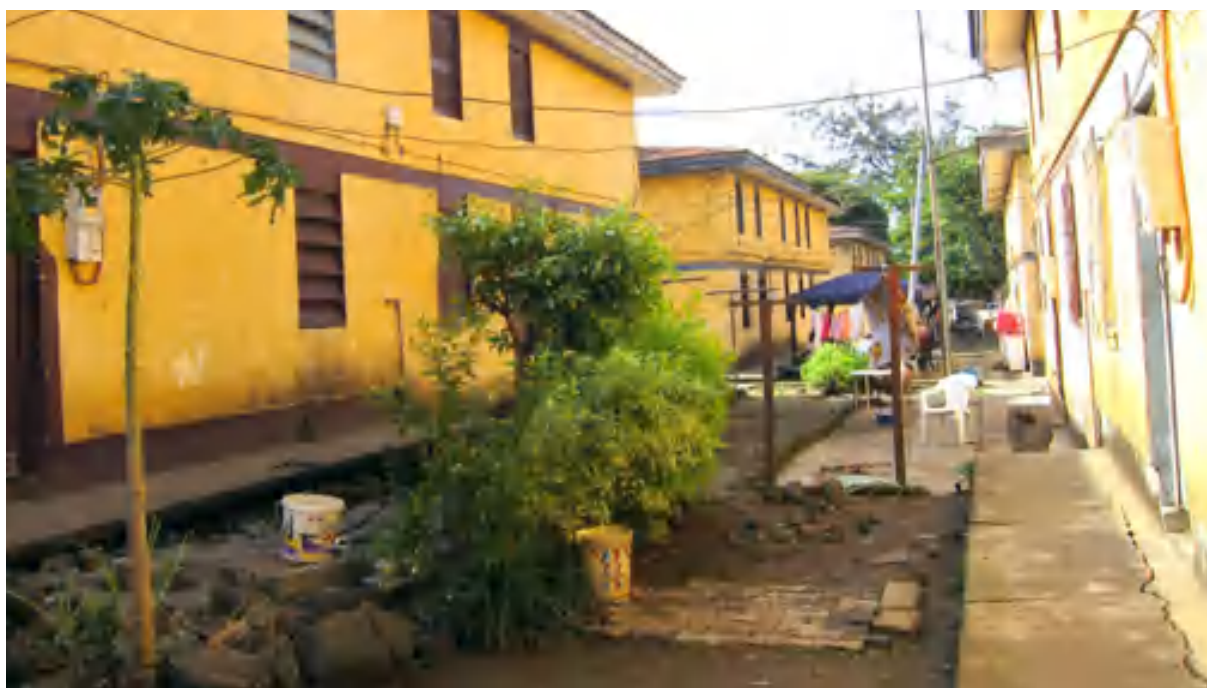
Figura 1. Perspectiva de las viviendas de un poblado modelo. Barrio Los Ángeles, Malabo, 2012. Imagen: © Patrimonio Guinea 2020.
