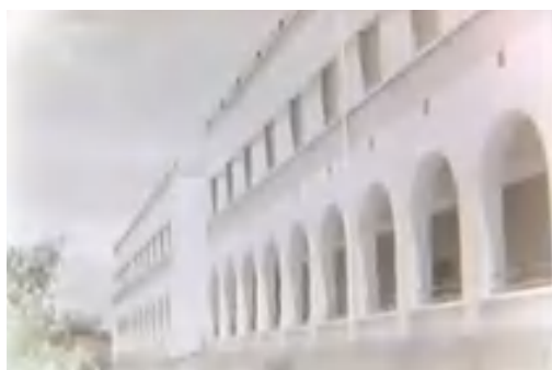
Figura 1. Colegio de los Huérfanos Ferroviarios, Torremolinos (Málaga). F. Alonso Martos, 1933-1936, en La vida de los ferroviarios y sus colegios de huérfanos (Tomás Aznar, 1944).
