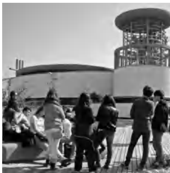
Figura 1. Trabajo de campo sobre la iglesia de Campuzano en Torrelavega con alumnos de 2.º de Bachillerato (registro DOCOMOMO: «Los equipamientos modernos», Ricardo Lorenzo, 1961-1968). Imagen: Javier Encinas Hernández.
