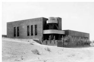
Central térmica de la Ciudad Universitaria, en colaboración con Manuel Sánchez Arcas
