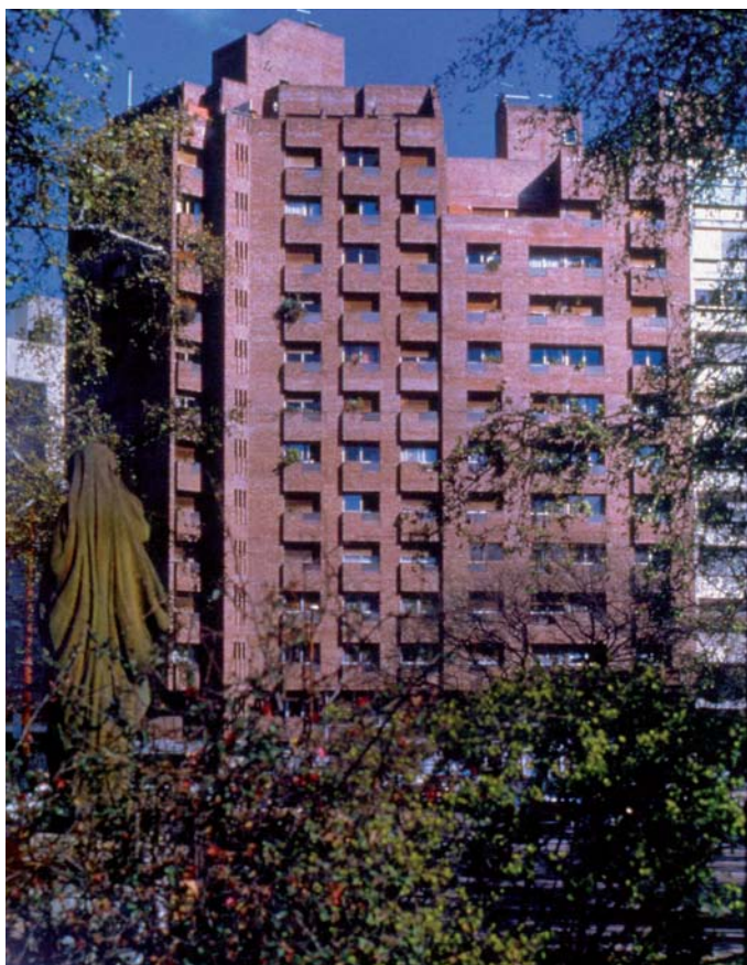
Díaz J. I. Edificios Panorama I y II. Córdoba, 1970-1971. Atención Arq. Togo Díaz. Archivo CEDODAL.
