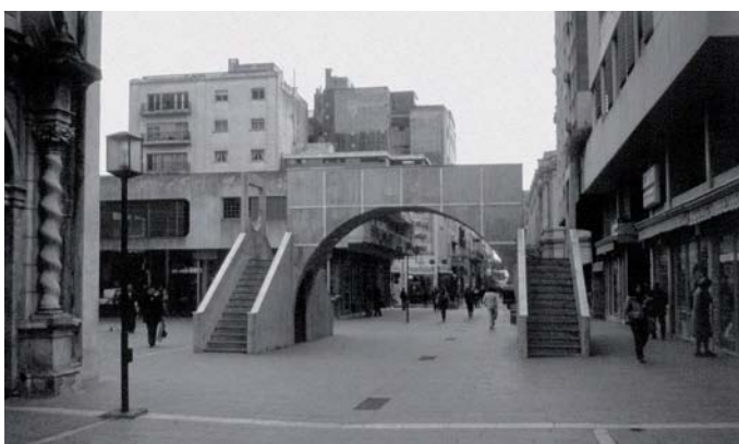
Roca M. A. Puerta-puente sobre peatonal del Centro Histórico. Córdoba, 1980. Foto Dick Alexander. Archivo CEDODAL.
