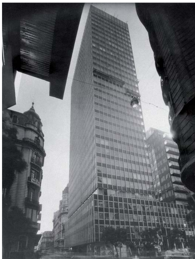
Pantoff-Fracchia. Edificio Olivetti. Buenos Aires, 1962. Archivo CEDODAL
