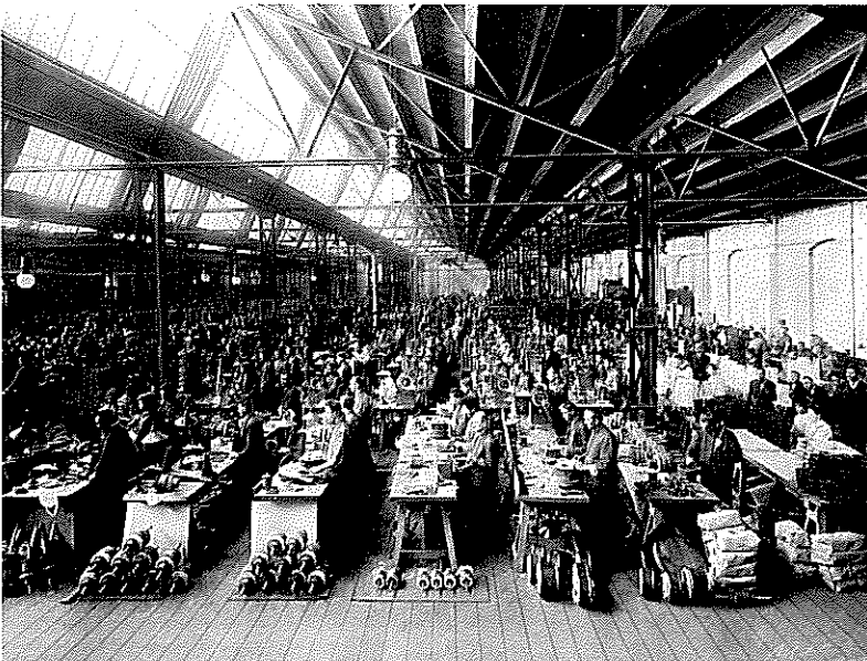
Antigua fábrica para maquinaria, AEG, Berlin, 1900, Peter Behrens.
