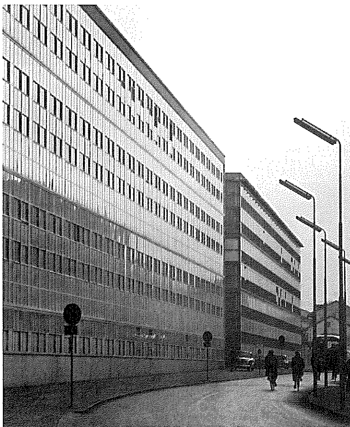
Instalaciones de Olivetti en Ivrea. Las ampliaciones segunda (1939-40; 1947-49) y última (1956-57) de las oficinas, de Luigi Figini y Gino Pollini.
