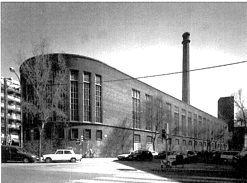
Fabrica de la empresa textil Buenaventura Costa y Font SA, Barcelona, 1946, Francesc Mitjans. Ampliada en 1965 y 1974 por Manuel Ribas i Piera.
