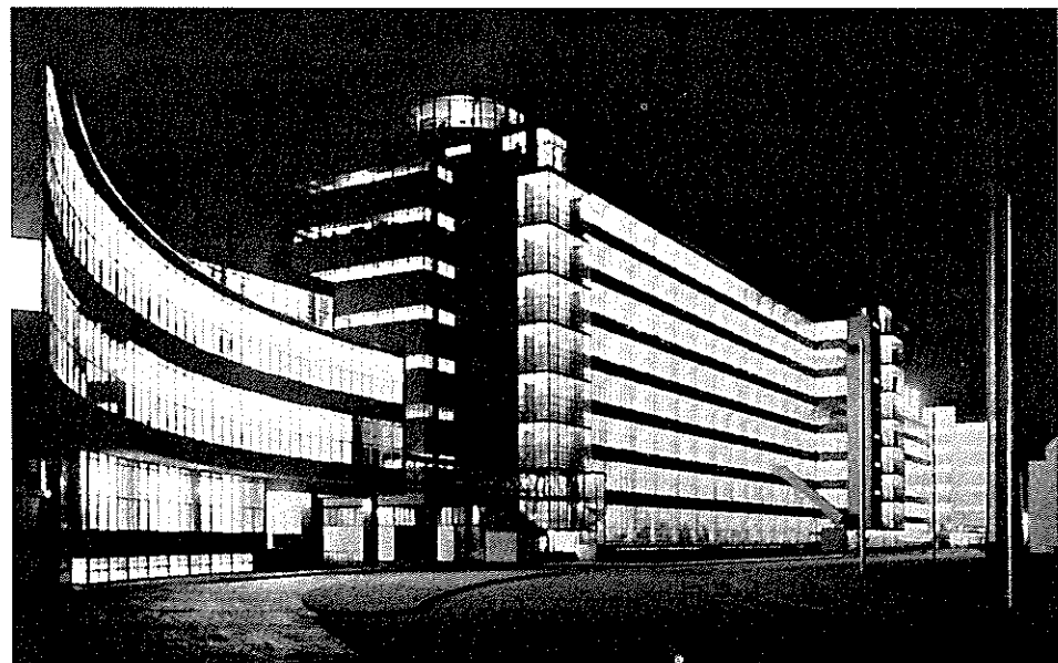
Factoría Van Nelle, Rotterdam, 1926-1929, M. Brinkman, J.A. Brinkman, Van der Vlugt.
