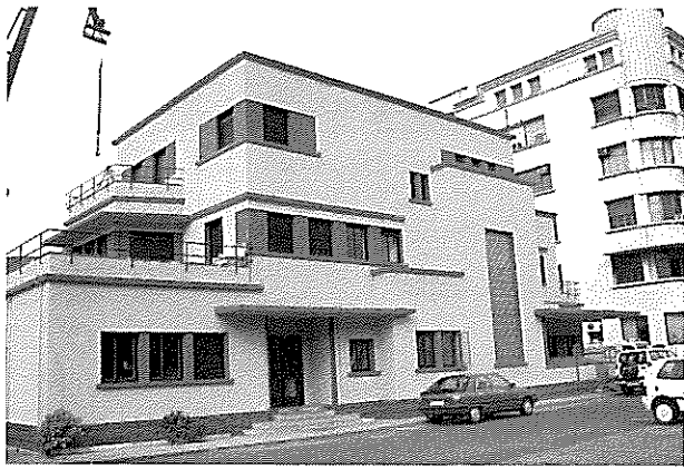
Edificio para los Servicios de Sanidad, Puerto de Pasajes.
