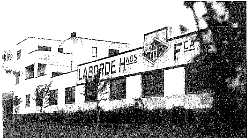
Fábrica Laborde Hermanos SA, Andoain, edificio originario, años 40.
