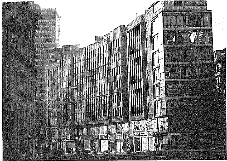
Avenida Jiménez, Bogotá, Karl Brunner, 1938. Los bordes de la avenida se fueron consolidando a finales de los 30 y comienzos de los 40.
