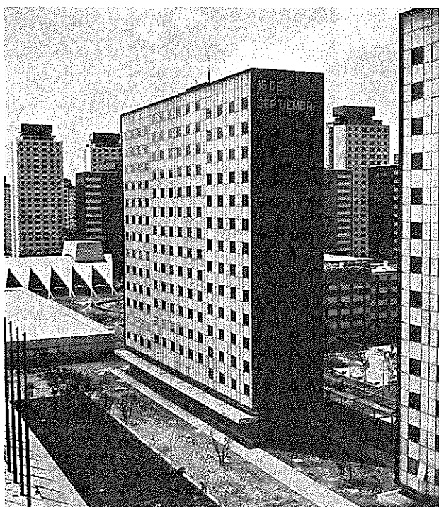
Ciudad Tlatelolco, detalle del interior del conjunto.
