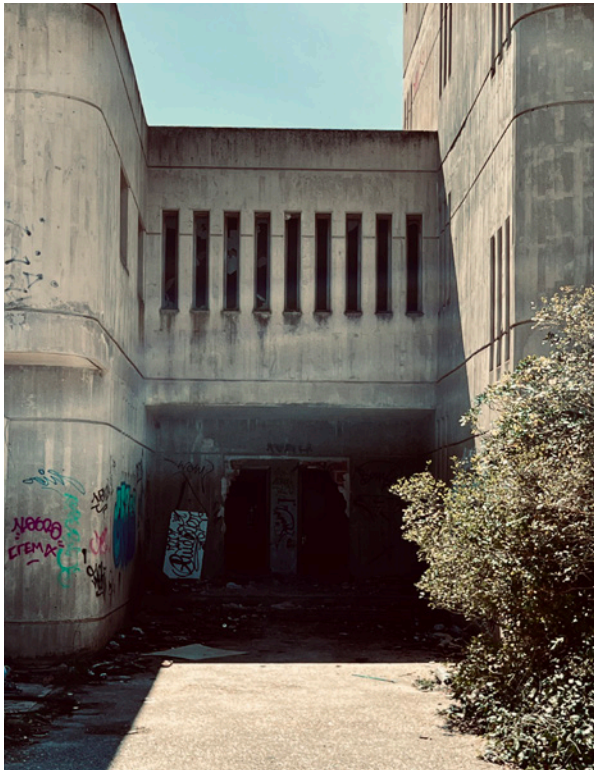
Figura 9. Acceso de servicio, sin servicio (Fotografía: David Gª-Manzanares)
