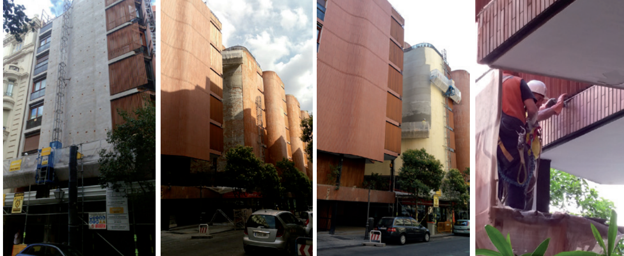
Figura 9: Fotografías del proceso de obra.
