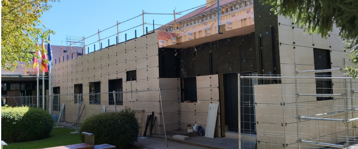
Figura 8. Instalación de la fachada cerámica ventilada.
