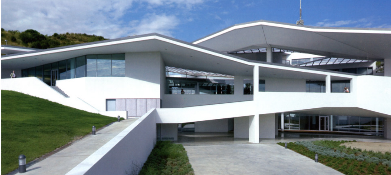
Figura 7: Llinás. Instituto Microbiología ocular. Barcelona. Detalle
