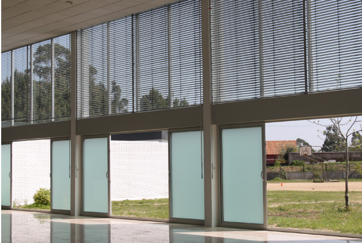
Figura 4. Colegio Saladino Cortizo. Vista interior del salón de actos finalizada la rehabilitación.
