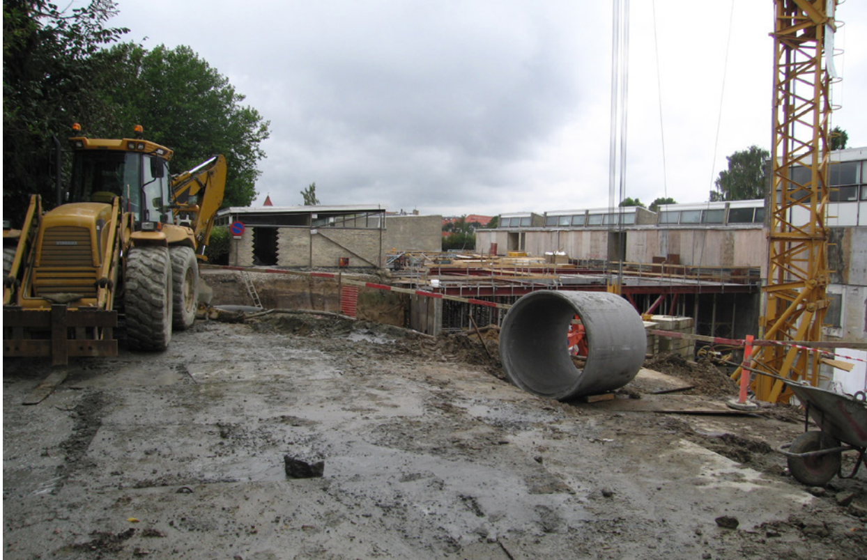
Figura 6. Colegio Munkegaard. Arne Jacobsen. Fotografía de las obras de rehabilitación. Zona de acceso y ampliación, 2006.
