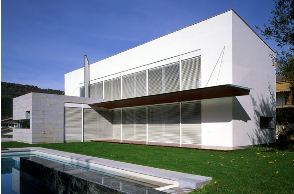
Figura 7. Fachada sur de la Casa Margarida (1988-1989) en Olot, de RCR.
