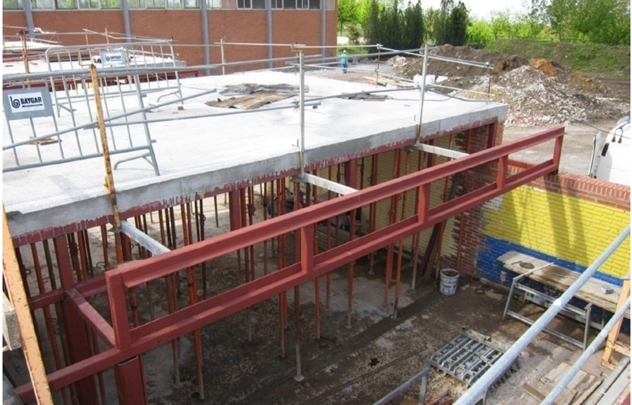
Figura 7. Colegio Saladino Cortizo. Fotografía de las obras de rehabilitación. Zona de talleres, 2010.
