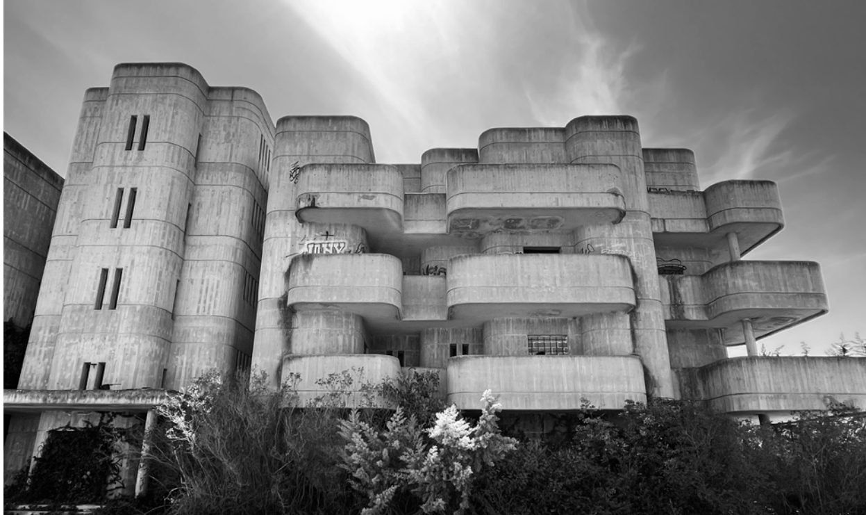
Figura 10. Las curvaturas de los muros del Claridge, palpando un pliegue en el continuo espacio-tiempo (Fotografía: David G a -Manzanares)
