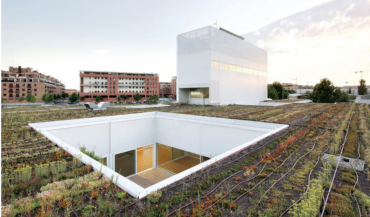
Figura 9. Vista de la cubierta ajardinada del Centro de Ocio para mayores de Azuqueca de Henares, en Guadalajara (2007-2011), de Iñaki Ábalos y Renata Setkiewiczzhabitat
