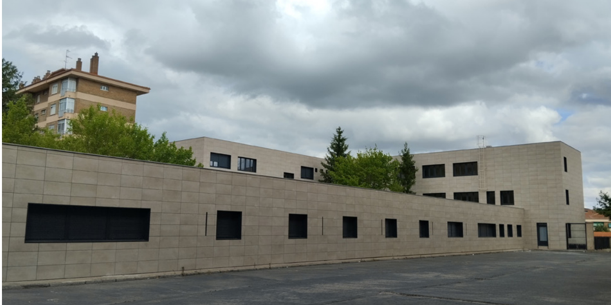
Figura 10. Cuerpo Oeste tras la instalación del SATE.
