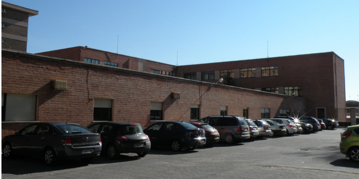
Figura 9. Cuerpo Oeste en estado previo a la instalación del SATE.
