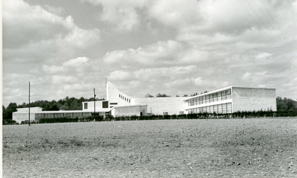
Fig. 5: Instituto de Valdepeñas. Vista general.
