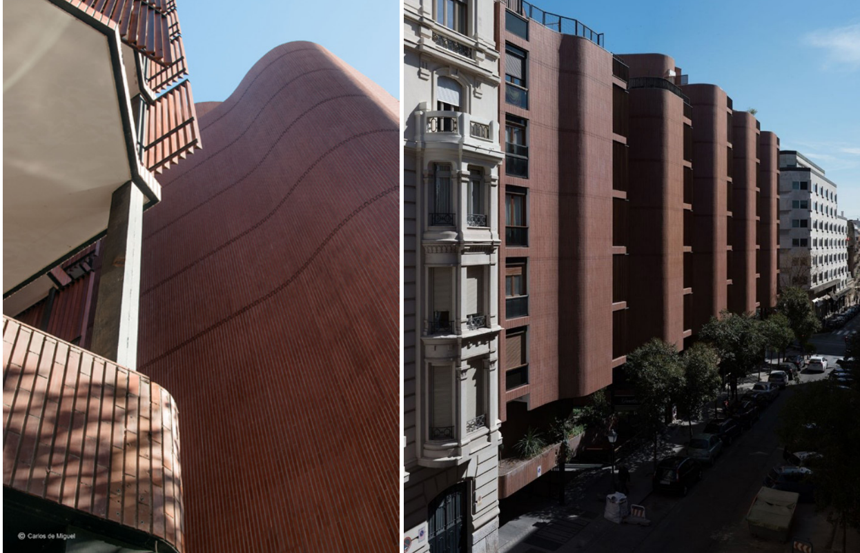
Figura 10: Fotografías finales tras la rehabilitación.
