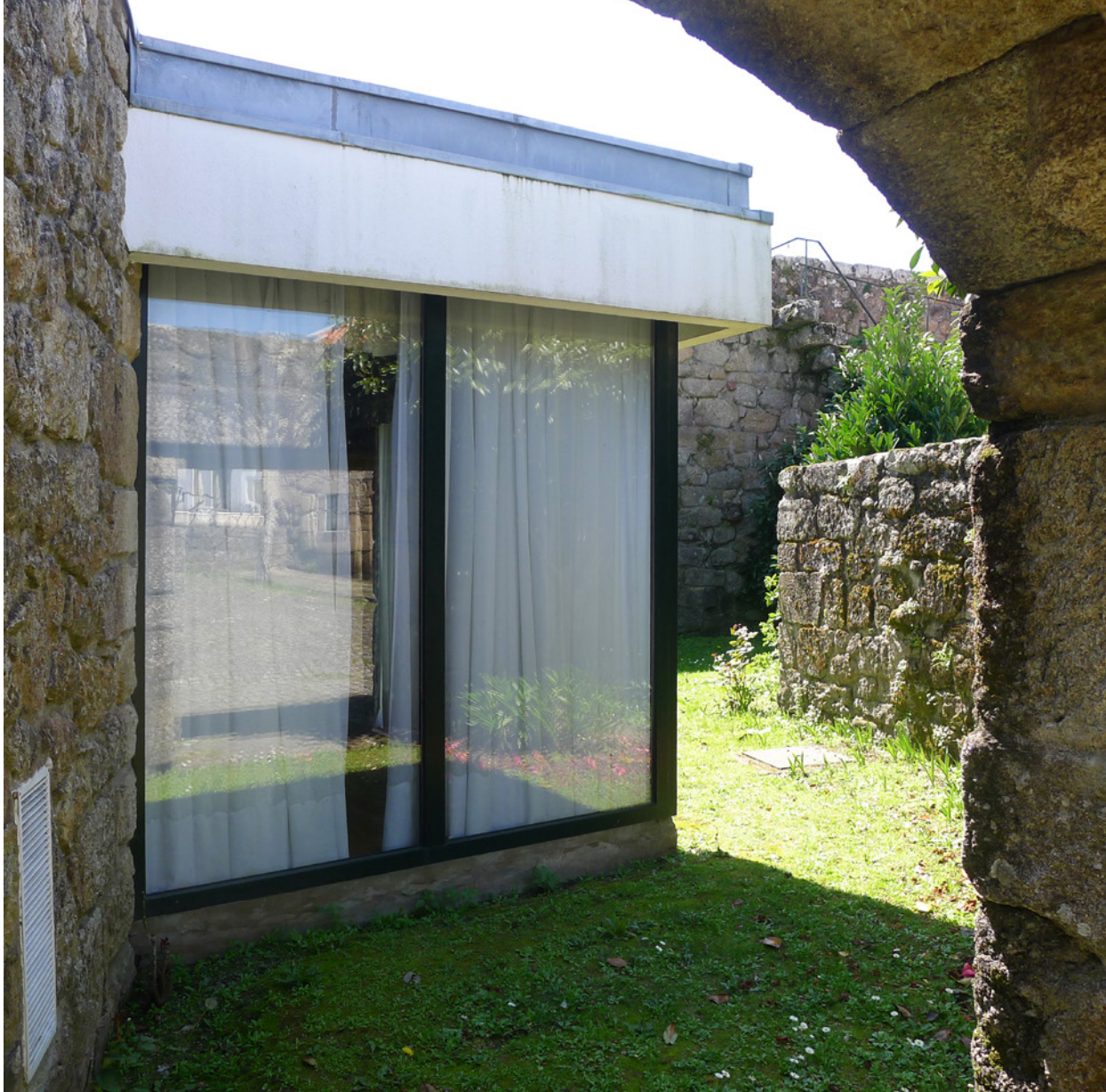
Figura 2: A ruina existente e o novo (Cerveira).
