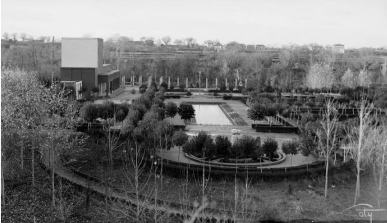
Figura 7: Vista exterior del conjunto
