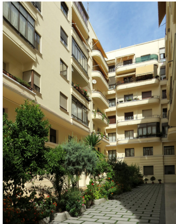
Figura 1: Vista del patio abierto a fachada. Antonio Vallejo Álvarez. Edificios de Viviendas para la Inmobiliaria AR-IN, en Calle Duque de Sesto 39-41, Madrid (1935-1941).
