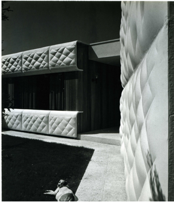
Figura 4: Piel envolvente de paneles de hormigón con encofrados flexibles, en la casa de D. Pascual de Juan Zurita
