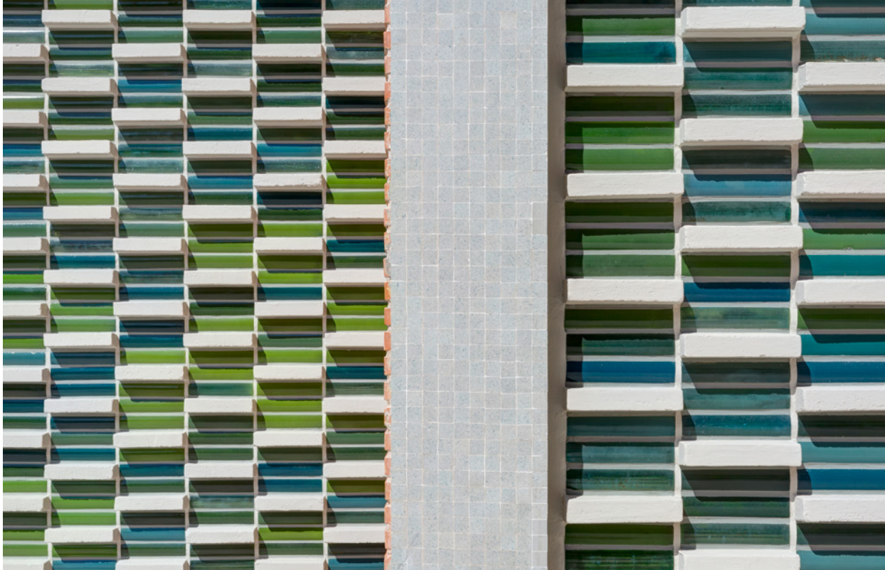
Figura 4: Vista exterior del muro de pavés de la iglesia después de la rehabilitación. Fotografía Celia de Coca
