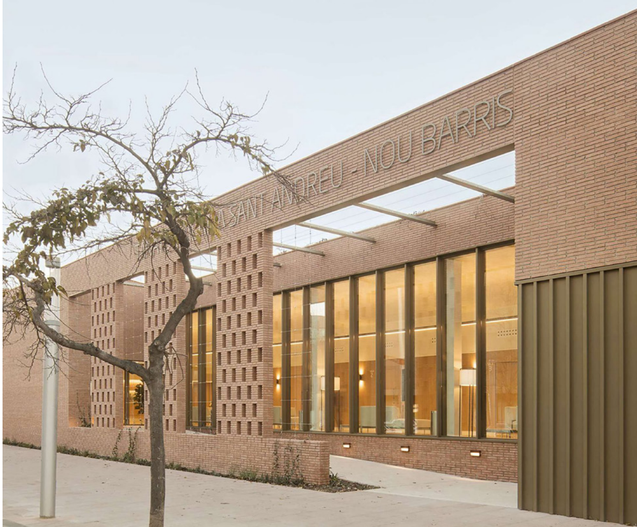
Figura 10. Vista de la fachada principal del Tanatorio Àltima en el barrio de Sant Andreu (2022), en Barcelona, de Batlle i Roig. www.batlleiroig.com
