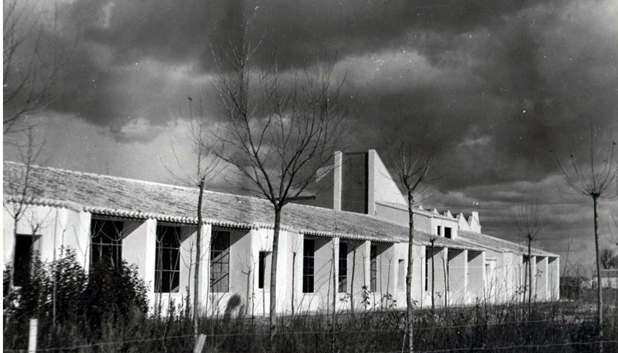
Fig. 2: Fachada de la zona de aulas. Fotografías Kindel.
