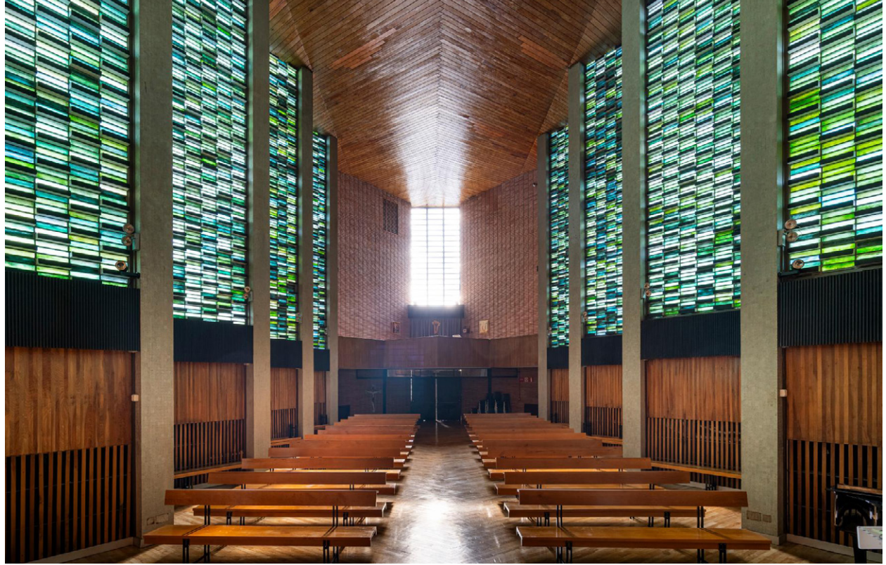
Figura 07: interior de la iglesia después de la restauración. Fotografía: Celia de Coca.
