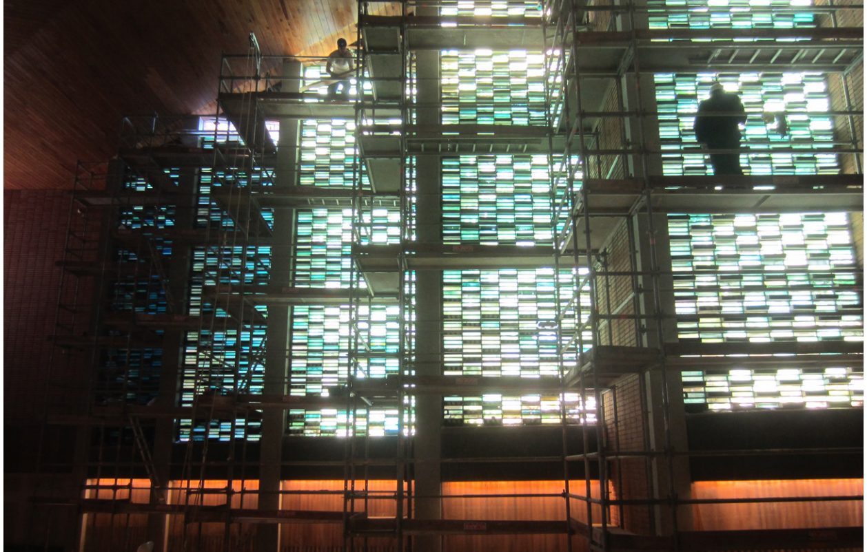
Figura 5: Interior de la iglesia durante la rehabilitación. Fotografía de i-bau arquitectos
