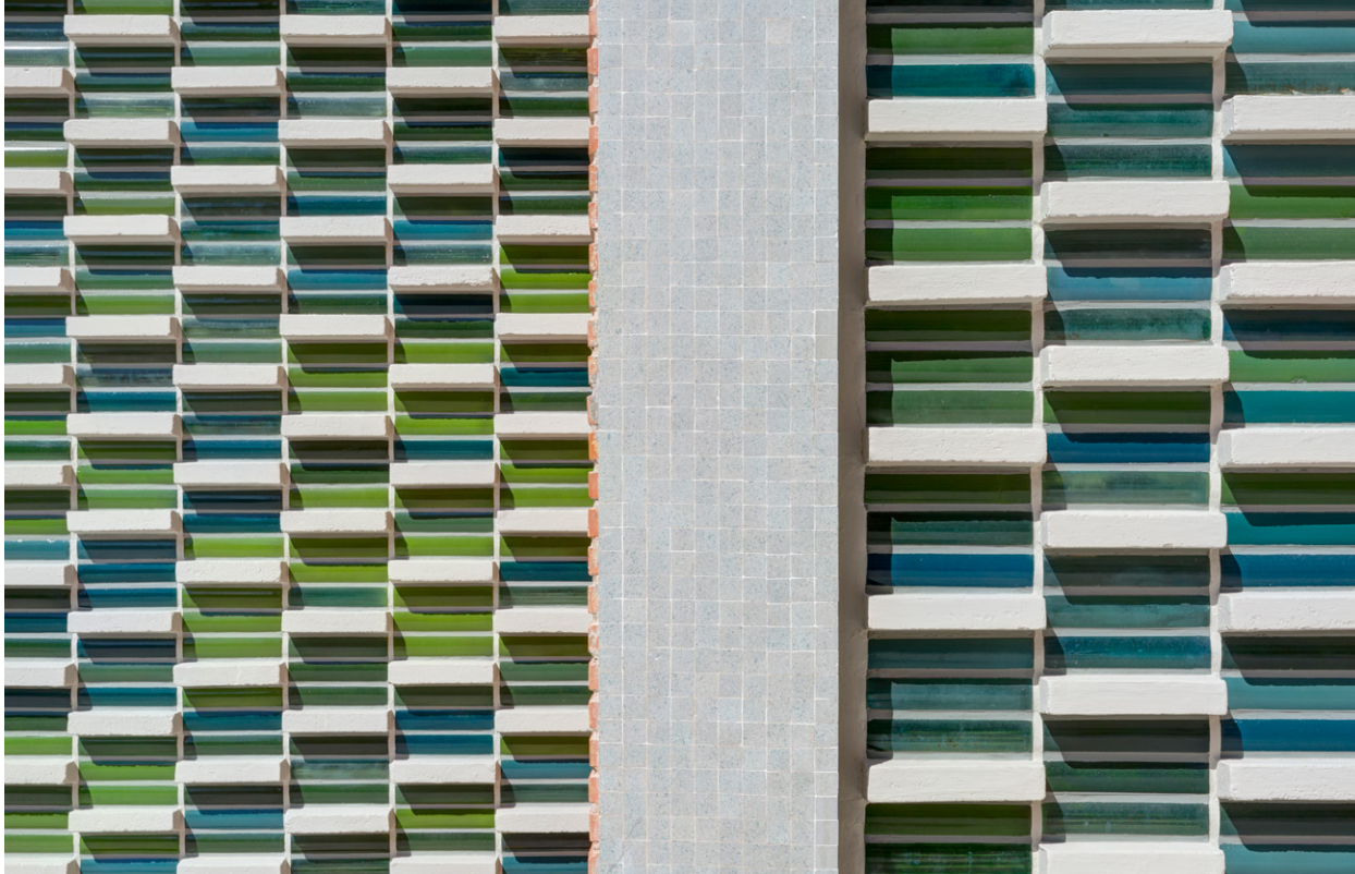
Figura 4: Vista exterior del muro de pavés de la iglesia después de la rehabilitación. Fotografía Celia de Coca
