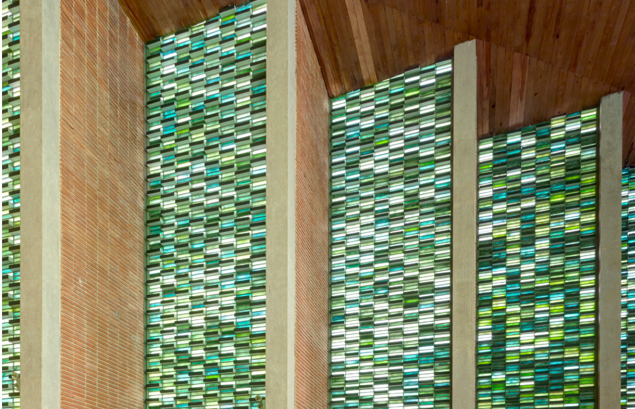
Figura 6: Detalle de las vidrieras de la iglesia después de la rehabilitación. Fotografía de i-bau de arquitectos
