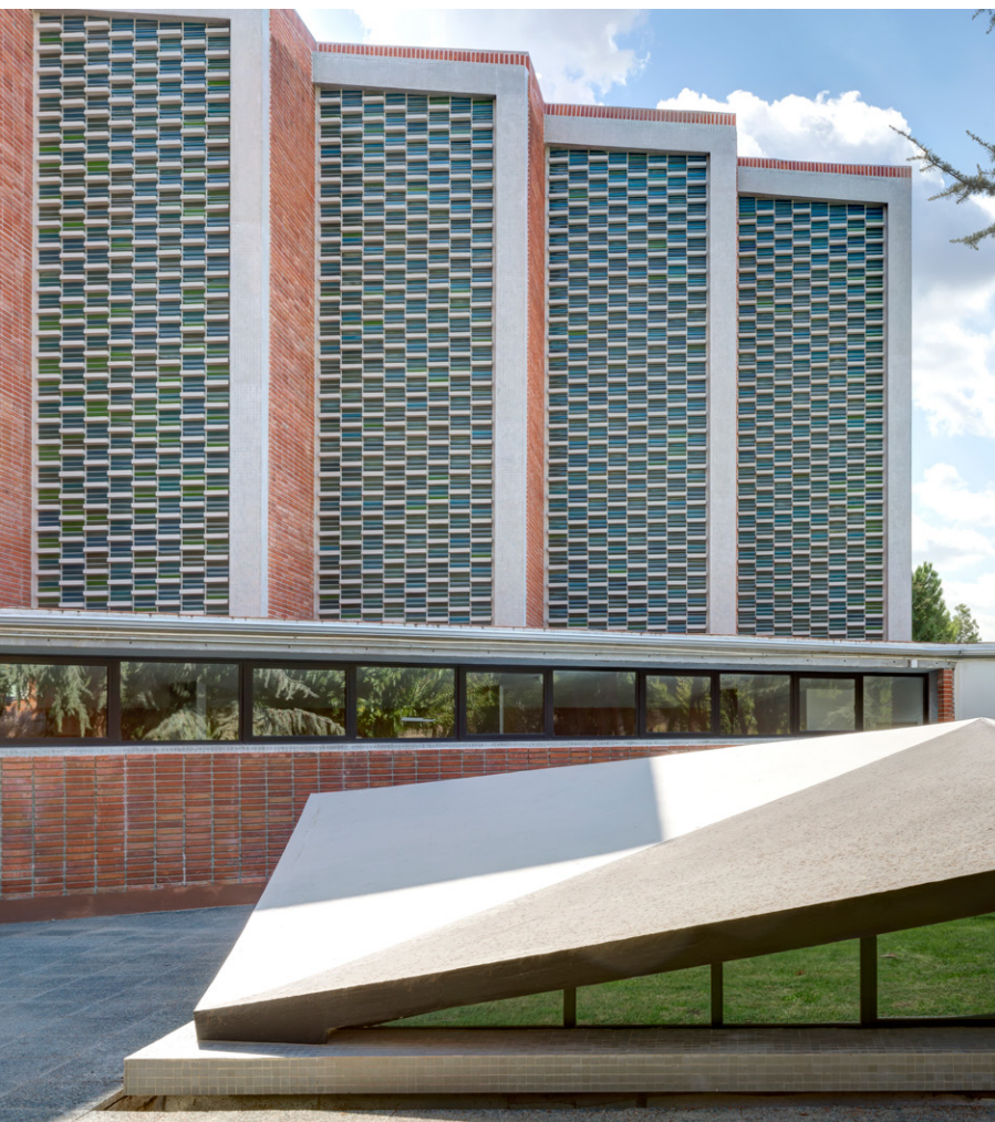
Figura 1: Vista del exterior de la iglesia
