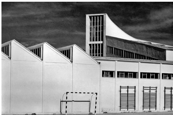
Figura 6: Instituto de Enseñanza Media, Málaga. Vista desde el patio de juego, de los dientes de sierra de los talleres con el muro de la capilla al fondo.
