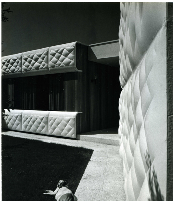
Figura 4: Piel envolvente de paneles de hormigón con encofrados flexibles, en la casa de D. Pascual de Juan Zurita
