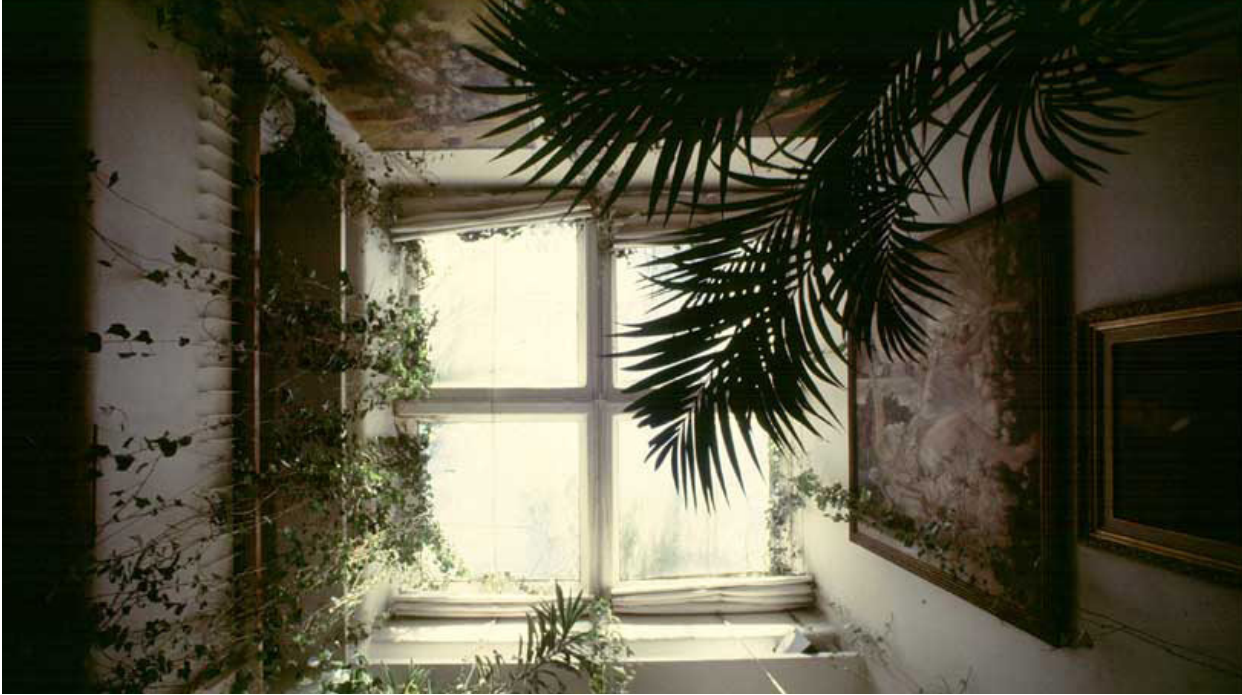
Figura 10. Vista de las claraboyas desde el interior.
